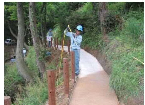
③ 散水状況
