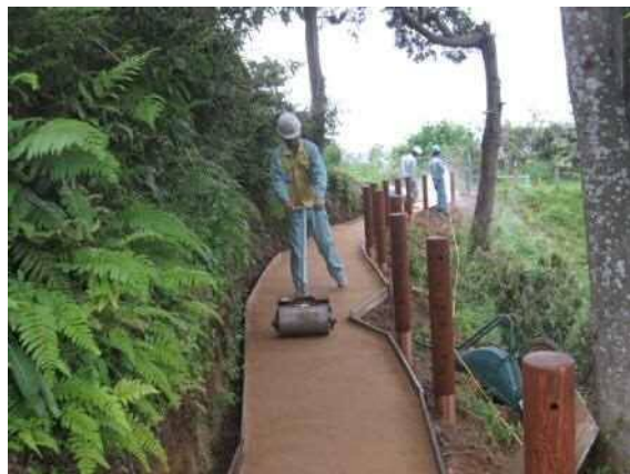
④ ローラー転圧状況
