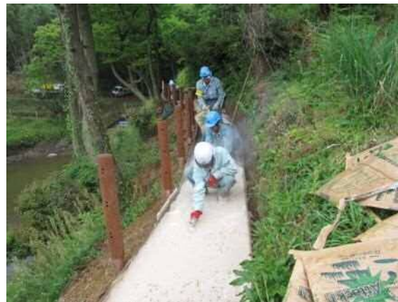
② 敷均し状況
