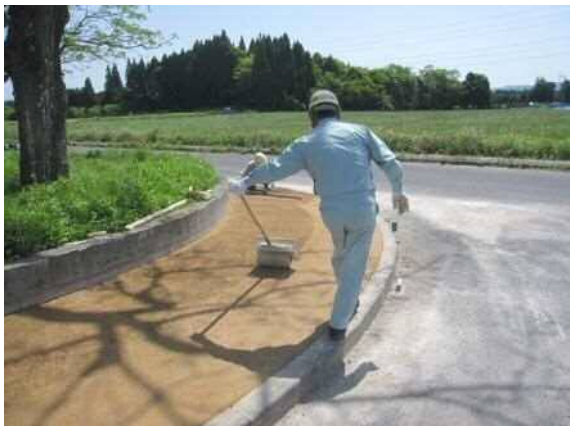
④ 転圧状況
