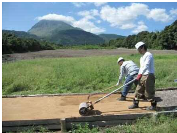
④ ローラー転圧状況
