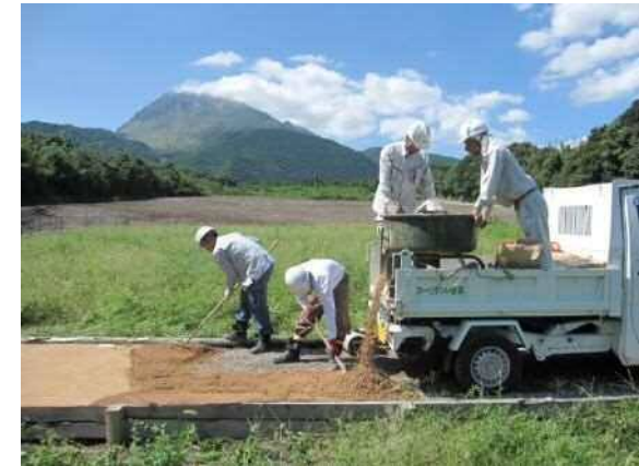
③ 敷均し状況
