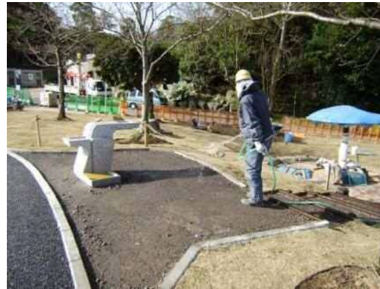
作業中(下地散水)
