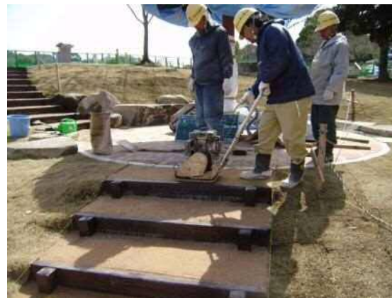
作業中(振動コンパクト転圧)
