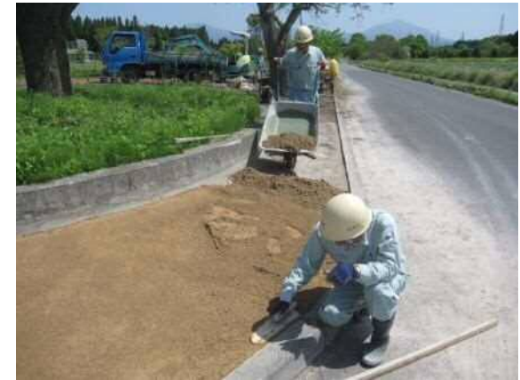
③ 敷均し状況
