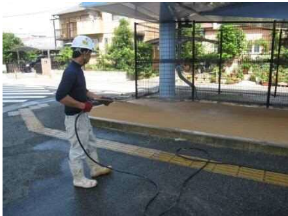
④ 散水作業中
