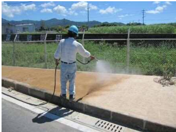
④ 散水作業中
