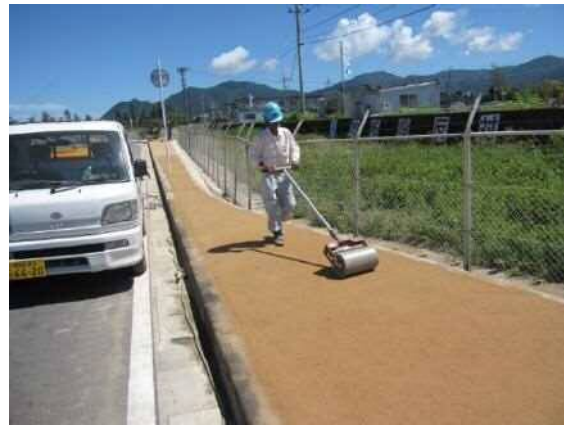
⑤ 転圧作業中
