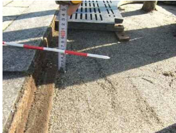
② 除根・下地処理完了
