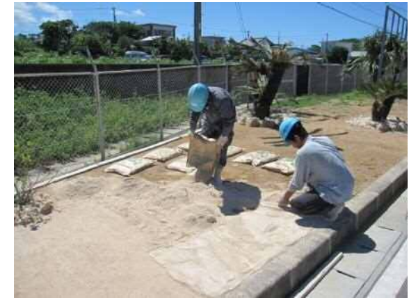
③ 敷き均し作業中
