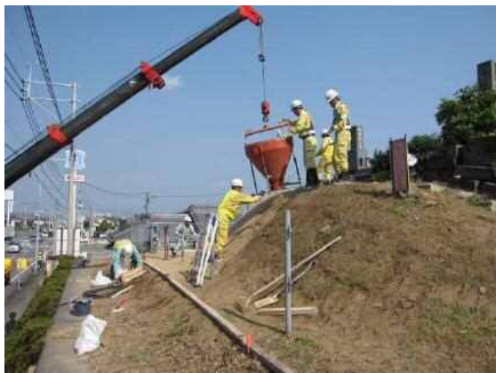
④ 敷き均し
