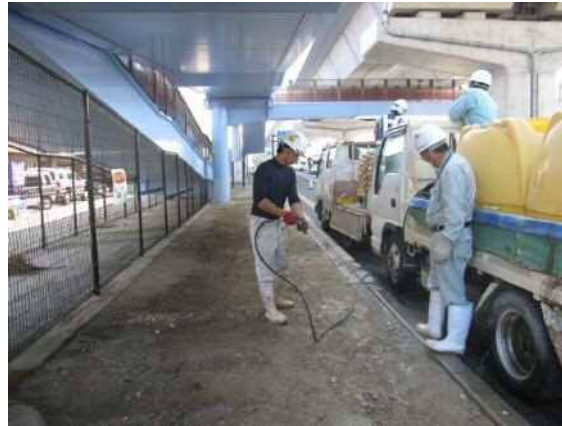
② 下地散水作業中
