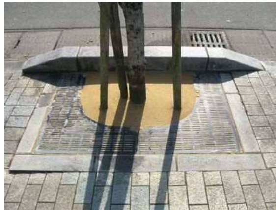
⑤ 幹回り敷均+散水完了
