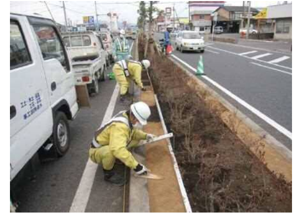
③ 敷き均し作業中
