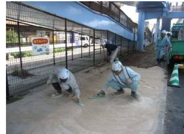
③ 敷き均し作業中
