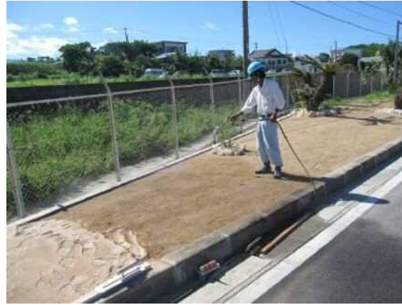
② 下地散水作業中
