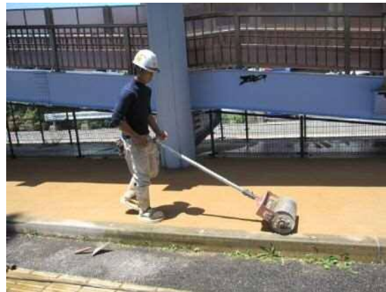
⑤ 転圧作業中
