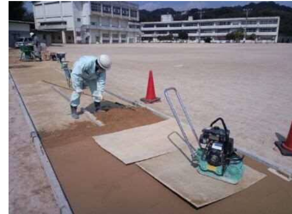
③ 敷均し状況
