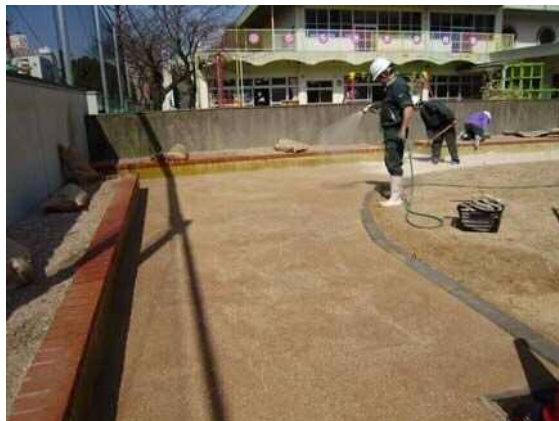
④ 散水作業
