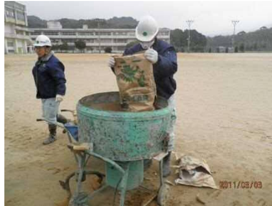
② 加水混合状況
