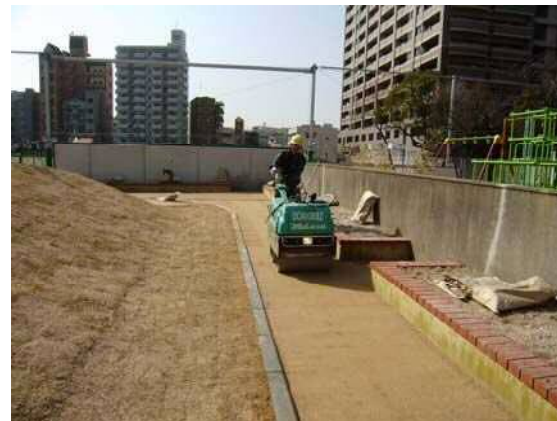
⑤ 転圧作業
