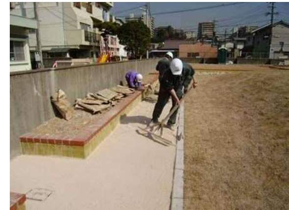
③ 敷均し状況
