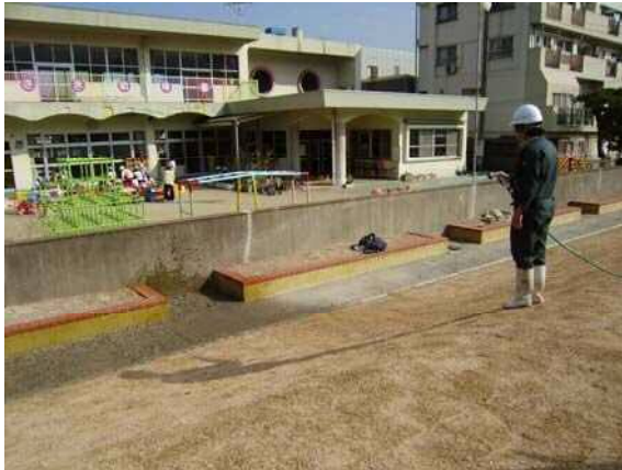
① 下地散水作業
